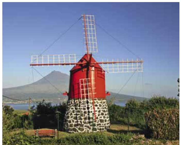
Windmühlen von Espalamarca (19./20. Jh.) - Zweistöckige Windmühlen, die teils unter portugiesischem Einfluss standen (erkennlich in dem System von acht Stöcken, die dreieckige Segel anbinden), teils unter flämischem Einfluss (sichtbar an den viereckigen Segeln). Einigen davon wurde ein besonderes öffentliches Interesse zugeschrieben und die Auszeichnung „Imóvel de Interesse Público“ verliehen.
